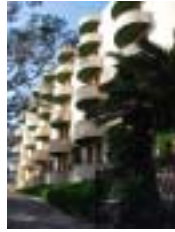
Balconies - Club Hispánico
